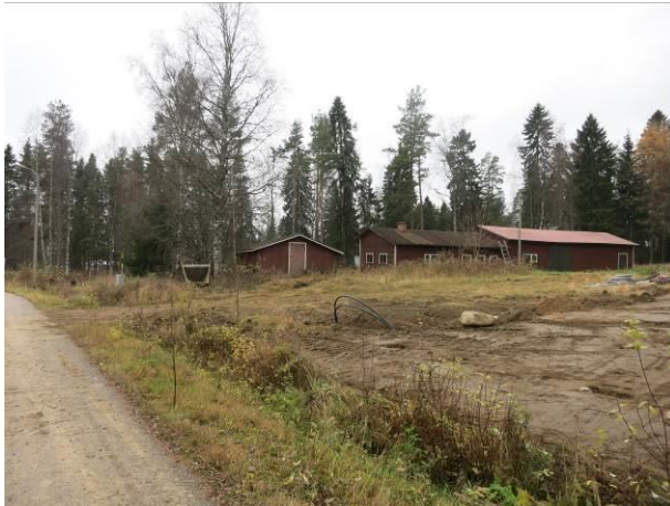
Vanhoja huonokuntoisia maatalan talousrakennuksia suunnittelualueen etelälaidalla
