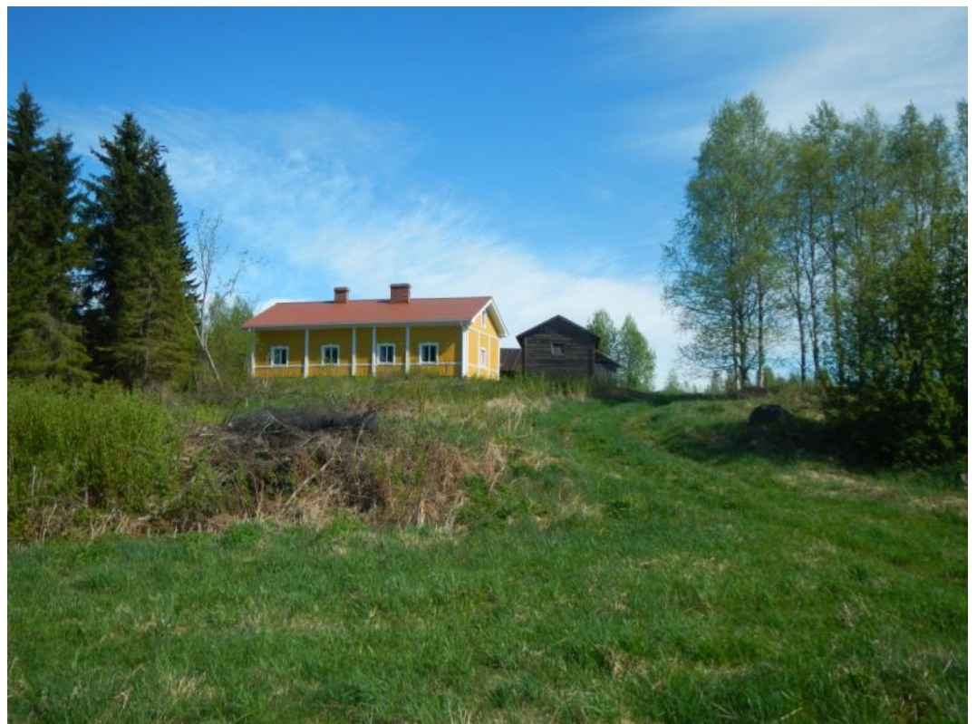
Kuva 10. Kemin päärakennus, kuvattuna etelästä.
