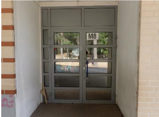
Kuva 24. Ulko-ovet ovat metallirakenteisia ja lasiaukollisia ovia
