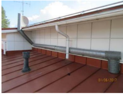
Kuva 26. Ilmanvaihtokanava katolla
