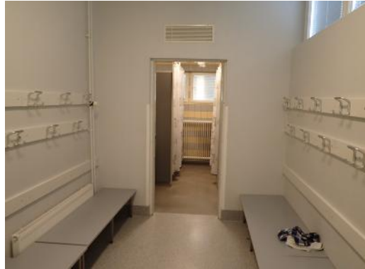
Kuva 50. Yleiskuva oppilaiden pesutilasta
