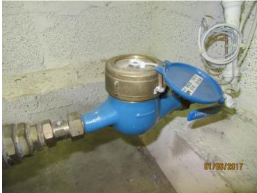
Kuva 3. Vesimittari
