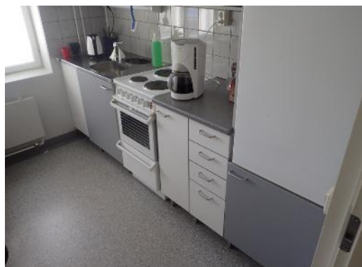
Kuva 45. Yleiskuva talonmiesten ja siivoajien taukotiiljen keittiöstä
