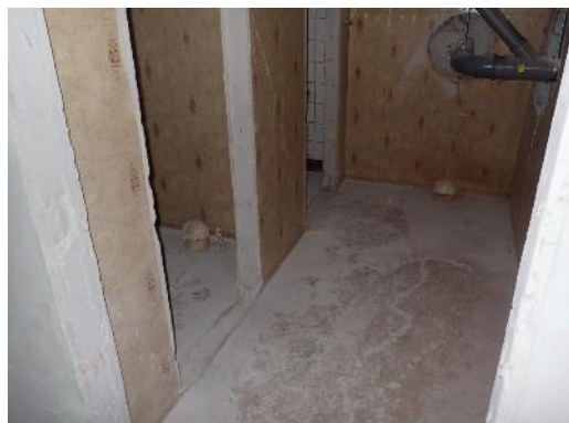
Kuva 53. Käytöstä poistettu suihku ja wc kellaritilassa
