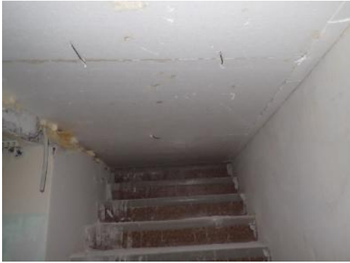
Kuva 54. Porras valettu umpeen
