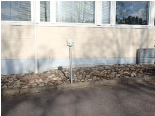
Kuva 5. Luonnonkivillä päällystetty alue
