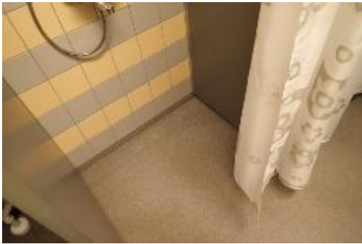
Kuva 51. Yleiskuva oppilaiden suihkutilasta
