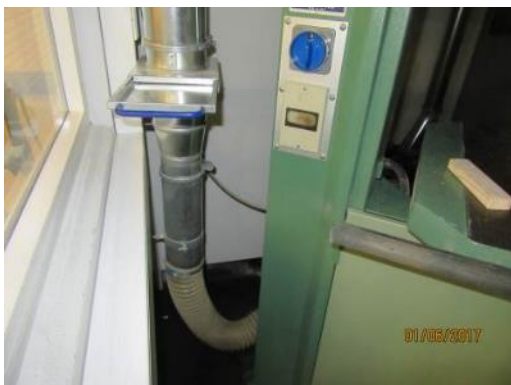
Kuva 37. Purunpoistojärjestelmän kohdepoisto
