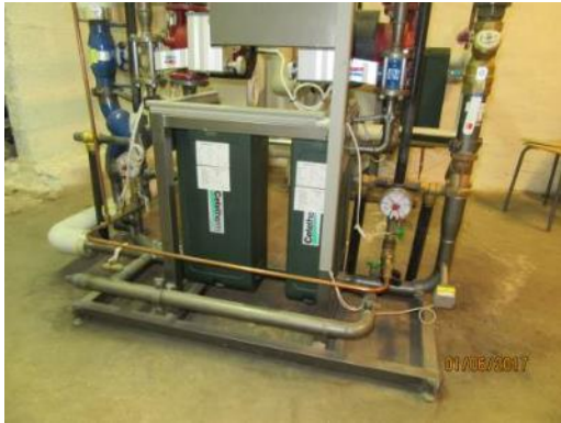
Kuva 57. Lämmönjakokeskus
