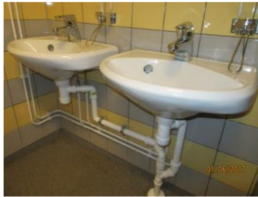
Kuva 6. Vesi- ja viemärikalusteet ovat kokonaisuutena hyvässä kunnossa
