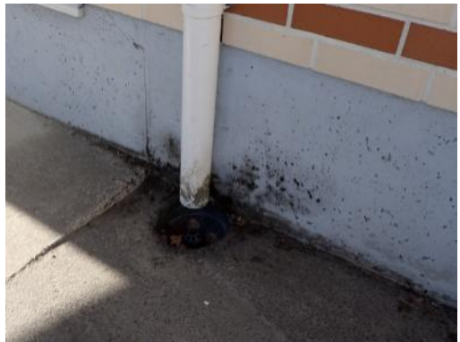
Kuva 10. Syöksyputkien loppupäät ovat suoria
