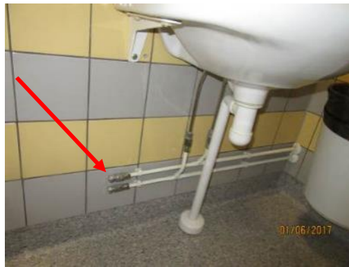
Kuva 8. Vesijohdot on tulpattu asianmukaisesti
