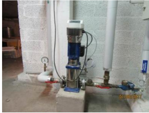
Kuva 4. Paineenkorotuskoneikko
