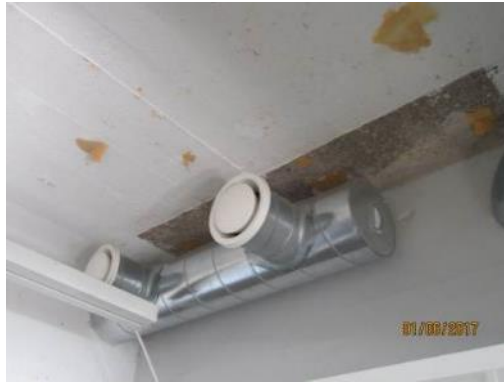
Kuva 30. Poistoilmaventtiilit
