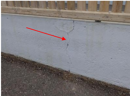
Kuva 7. Betonimuurissa halkeilua
