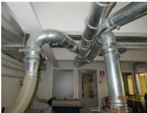
Kuva 36. Purunpoistokanavia
