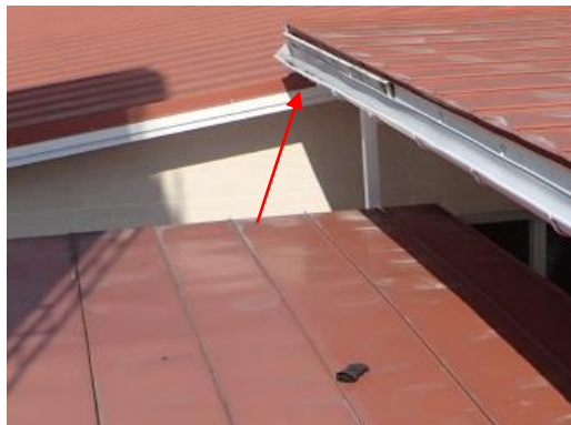
Kuva 12. Sadevesikouru vääntynyt
