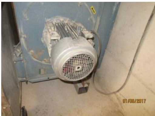
Kuva 35. Purunpoistopuhallin
