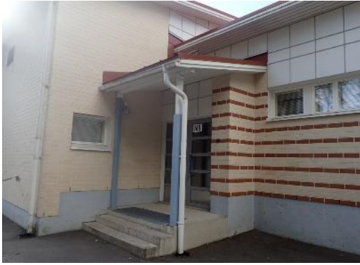
Kuva 25. Sisäänkäyntien edustalla teräs-/puurakenteiset katokset sekä osassa betoniset portaat
