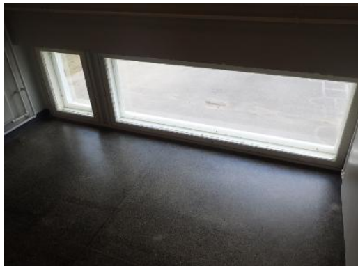
Kuva 22. Portaassa sijaitseva ikkuna
