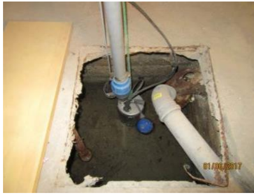
Kuva 14. Lämmönjakohuoneen perusvesipumppu
