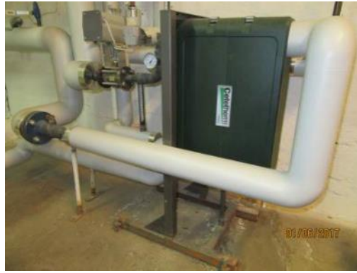
Kuva 58. Lämpimän käyttöveden lämmönsiirrin
