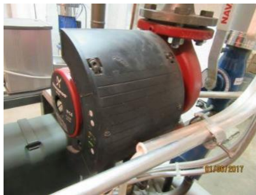
Kuva 60. Lämmitysverkoston kiertovesipumppu
