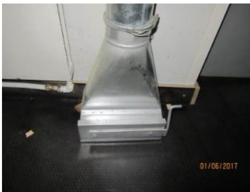
Kuva 38. Purunpoistojärjestelmän kohdepoisto
