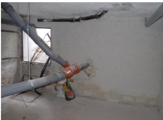
Kuva 52. Yleiskuva suljetusta kellaritilasta
