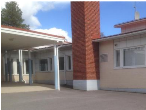
Kuva 29. Tiilirakenteinen piippu sisäpihalla
