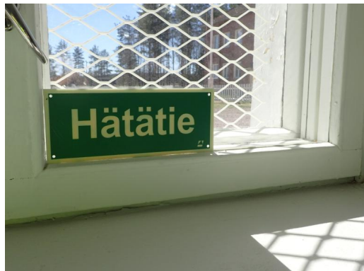
Kuva 17. Ruokalan hätäpoistumistieikkunan kohdalla teräsverkko
