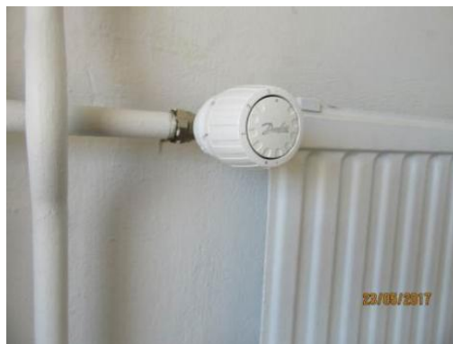
Kuva 6. Termostaattinen patteriventtiili
