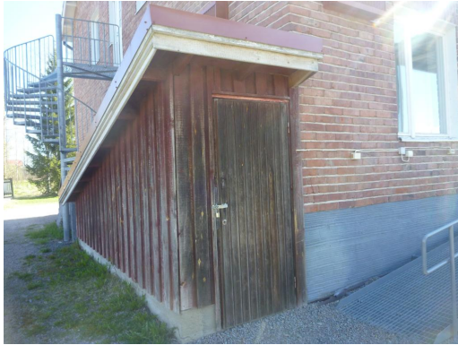
Kuva 28. Luoteispäädyn puinen katos
