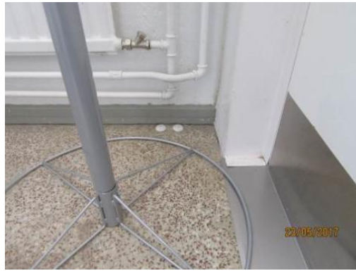
Kuva 8. Alapohjassa olleet lämpöjohdot on poistettu käytöstä
