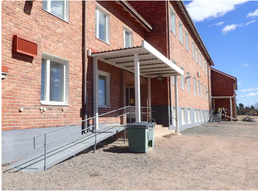
Kuva 24. Pääsisäänkäynnin portaat, luiska ja katos
