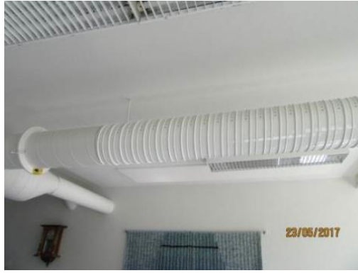
Kuva 26. Suutinkanava
