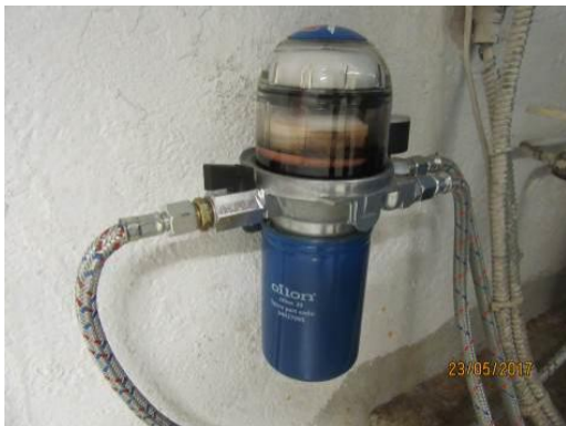
Kuva 59. Öljysuodatin
