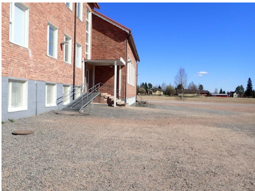
Kuva 1. Rakennusta ympäröivät alueet ovat sorapintaisia
