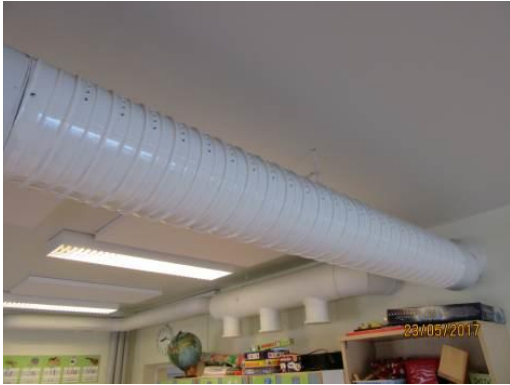
Kuva 25. Suutinkanava opetustilassa
