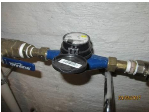
Kuva 9. Vesimittari
