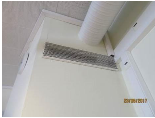
Kuva 28. Poistoilmaventtiili
