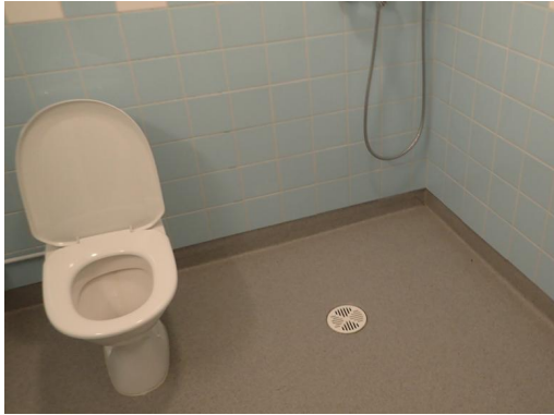
Kuva 51. Henkilökunnan pesuhuoneessa lattiapinnoitteena oli muovimatto
