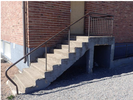
Kuva 26. Betoniportaavat rakennuksen päädyssä
