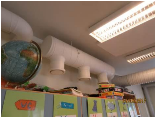
Kuva 27. Poistoilmaventtiilit
