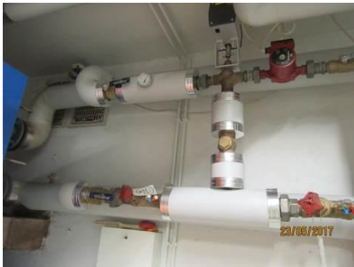
Kuva 1. Lämmitysverkon säätöventtiili
