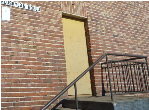
Kuva 21. Rakennuksen kaakkoispäädystä oven ulkopuolelle asennettu vanerilevy
