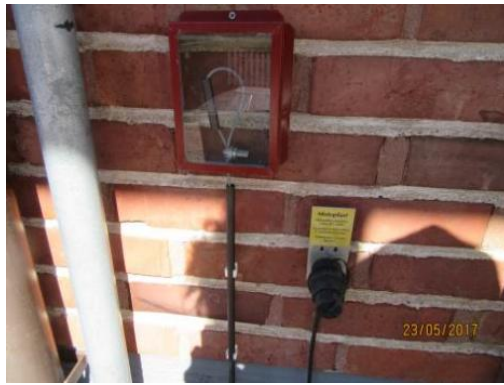
Kuva 2. Öljysäiliön ylitäytönestin ja öljyjohdon hätäsulku
