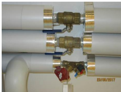
Kuva 10. Vesijohtojen venttiileitä
