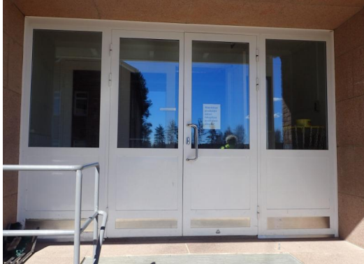
Kuva 18. Ulko-ovet ovat metallirakenteisia ja lasiaukollisia ovia
