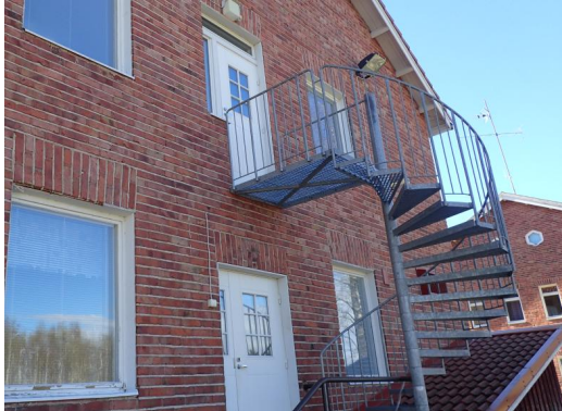
Kuva 19. Rakennuksen luoteispäädystä puurunkoiset ulko-ovet
