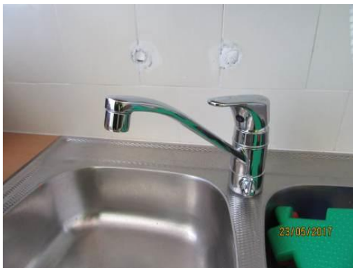
Kuva 13. Vanhojen vesijohtojen tulppaukset hanan yläpuolella
