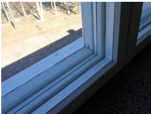
Kuva 14. Ikkunat ovat 3-puitteisia puuikkunoita
