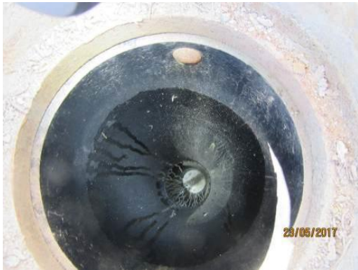
Kuva 17. Jätevesiviemärin tarkastuskaivo
