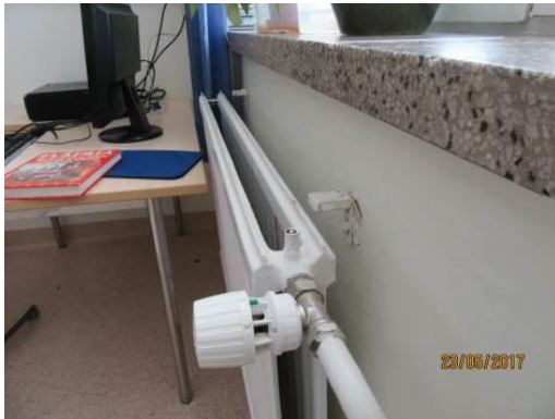
Kuva 7. Kannakkeistaan irronnut patteri
