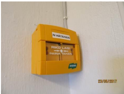
Kuva 21. Ilmanvaihdon hätäpysäytyspainike
