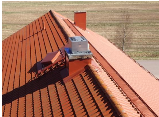
Kuva 38. Kattosilta ja kattoluukku
