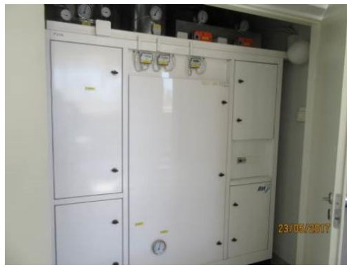
Kuva 22. Ilmanvaihtokone TK02
