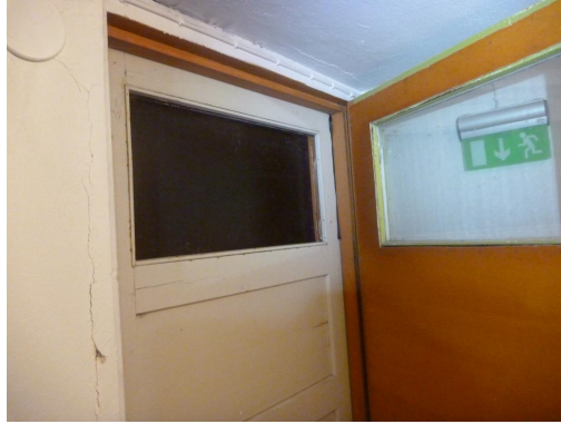
Kuva 23. Kaakkoispäädyssä sijaitseva kellarin ovi
