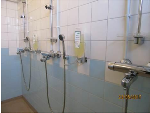
Kuva 11. Suihkuhanat ovat kunnossa
