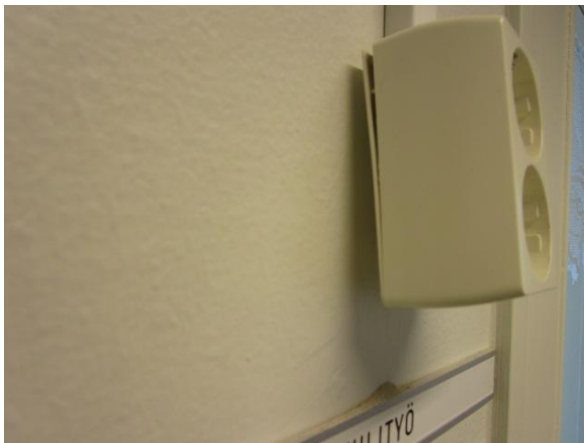
Kuva 36. Pistorasia on irti (tekstiililuokka).
