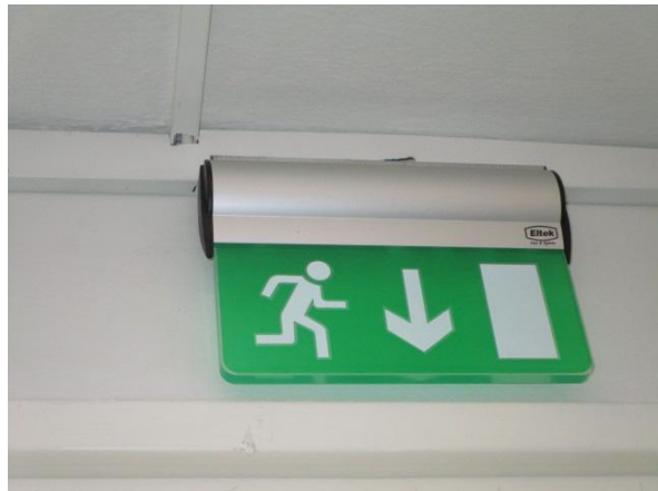
Kuva 43. Uusittuja poistumistievalaisimia.
