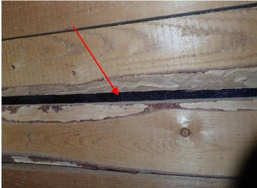
Kuva 31. Umpilaudoituksen yläpuolella aluskatteena bitumikermi
