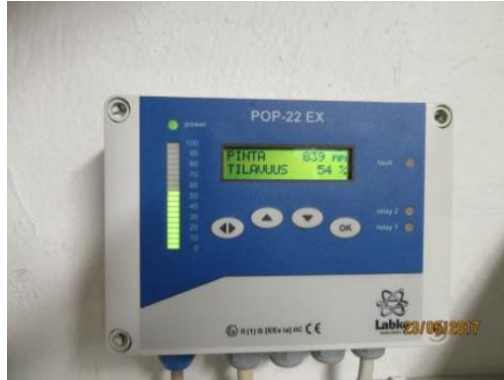
Kuva 4. Öljymäärämittari
