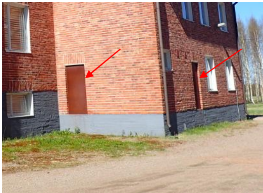
Kuva 20. Rakennuksen koillispuoleisella seinustalla kaksi tukittua oviaukkoa
