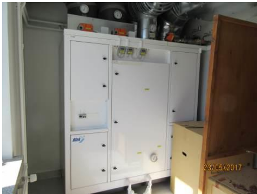
Kuva 23. Ilmanvaihtokone TK04
