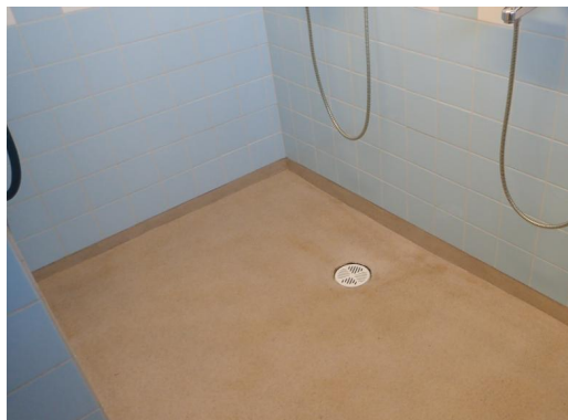
Kuva 54. Pesuhuoneen lattiassa akryylibetoni
