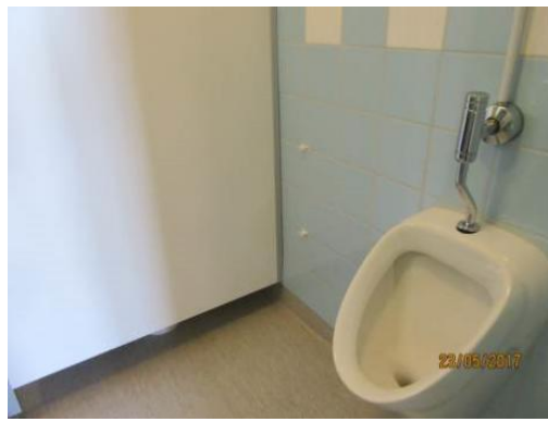
Kuva 14. Viemärlaitteiden kunto on hyvä
