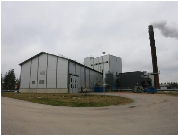
Näkymä Jouhtenentieltä. Edustalla lietekuivainlaitos, ja taustalla voimalaitoksen rakennukset omalla tontillaan. Tonttien välissä on jyrkkä kallioleikkaus.
