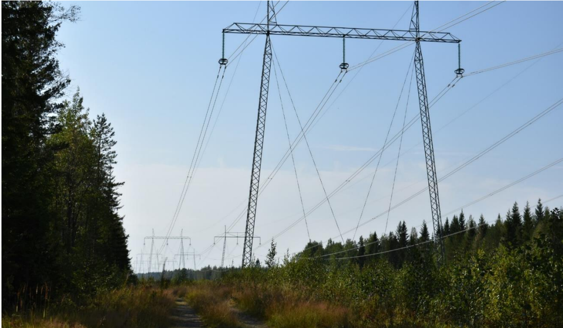
Kuva 12. Hankealueelle sijoittuu Fingridin 2 x 400 kV voimajohtokäytävä
