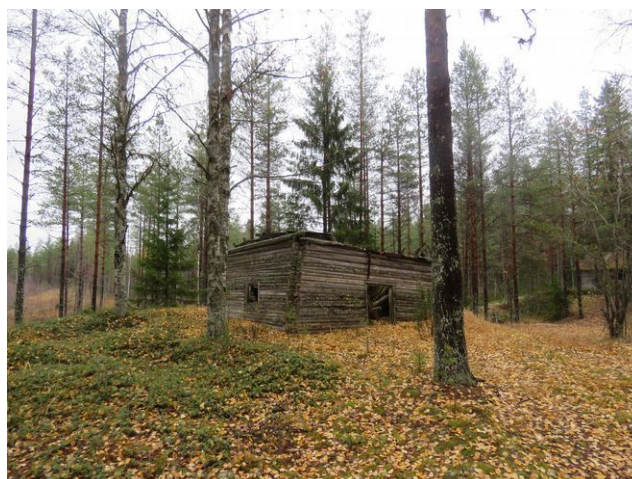
Talli kuvattu koilliseen.
