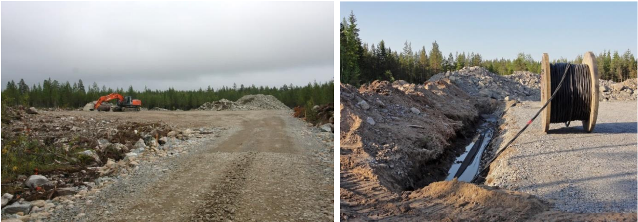
Kuva 9. Tuulivoimapuiston rakentaminen alkaa huoltoteiden ja pystytysalueiden rakentamisella. Maakaapelit upotetaan huoltoteiden yhteyteen (kuvat: Ville Suorsa, FCG).
