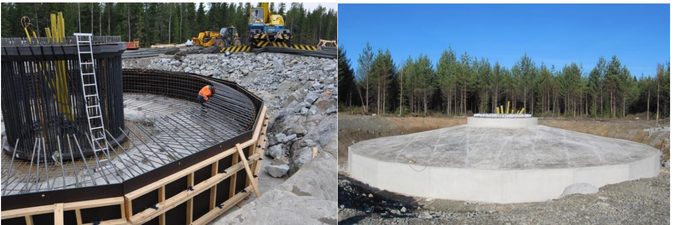
Kuva 10. Tuulivoimalan perustusten rakentamista. (Kuvat: Leila Väyrynen, FCG)
