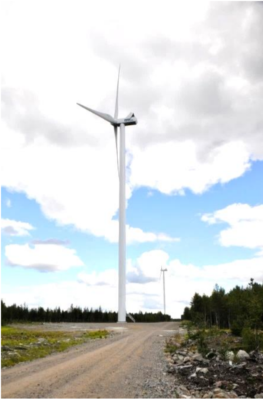
Kuva 2. Vasemmalla on esimerkki teräslieriötornista ja oikealla hybriditornista. (Kuvat: Leila Väyrynen ja Ville Suorsa, FCG)
