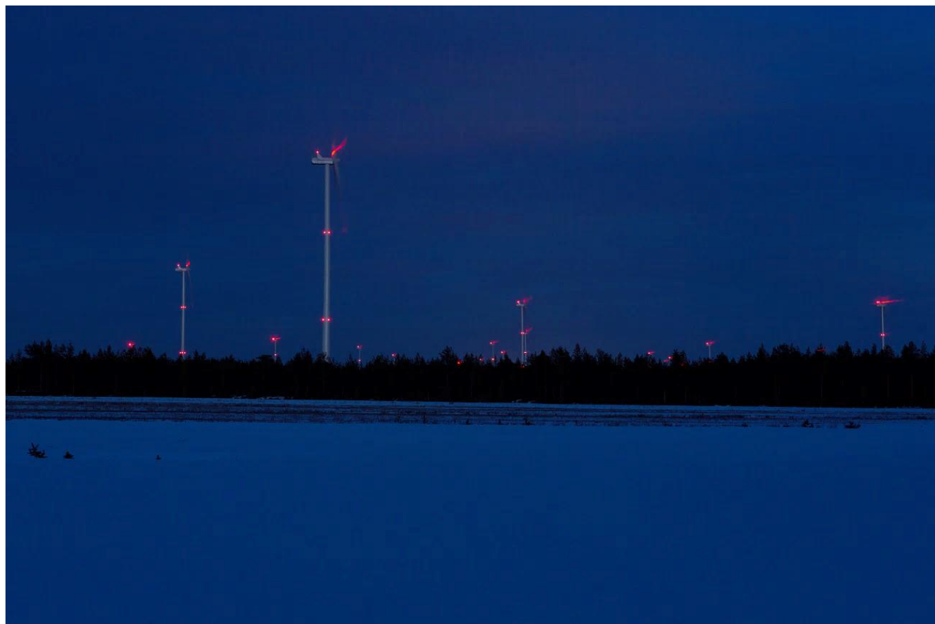
Kuva 4. Kiinteät punaiset lentoestevalot. (Kuva: Ville Suorsa, FCG)
