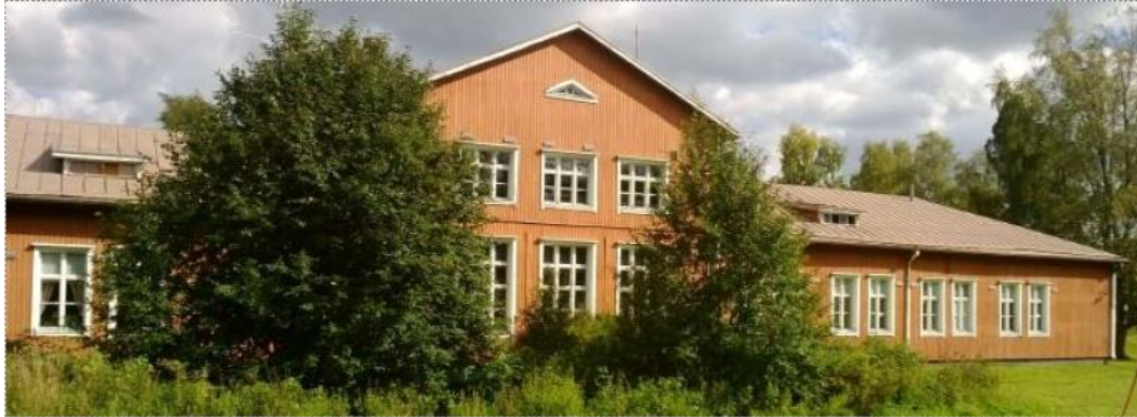
Vuonna 1926 valmistunut kunnalliskodin päärakennus kuvaaja: Kirsti Reskalenko kuvausaika: 2013
