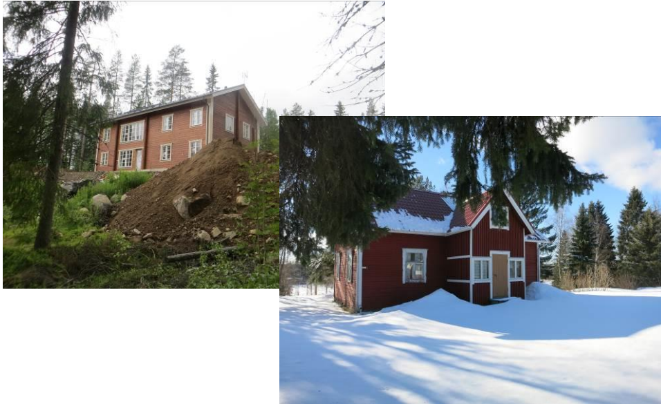
Uutta ja vanhaa rakentamista Vattukylällä
