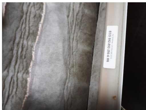
Kuva 32. Tuloilmasuodatin.
