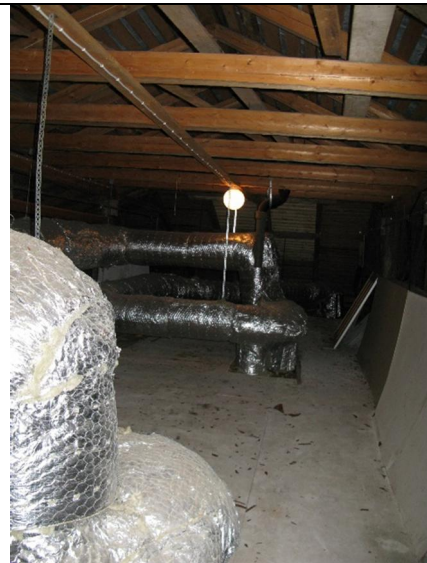
Kuva 29. Ilmanvaihtokanavat ullakolla.
