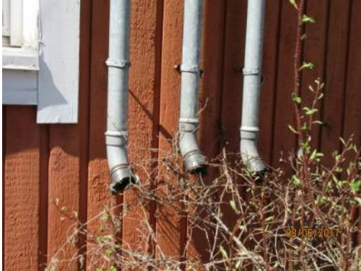
Kuva 74. Palokunnan syöttöliittimet
