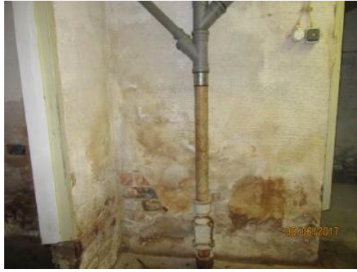
Kuva 52. Muoviviemärit liitetty vanhaan valurautaviemäriin
