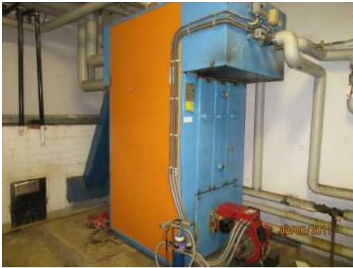
Kuva 74. Lämmityskattila
