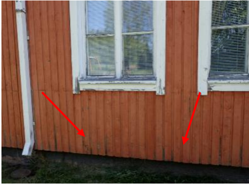
Kuva 26. Maalipinnoitteet huonokuntoiset
