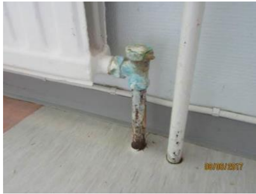
Kuva 83. Paluupuolen sulkuyhdistäjä
