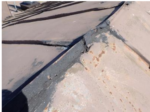
Kuva 48. Vesikatteen paikkakorjaus
