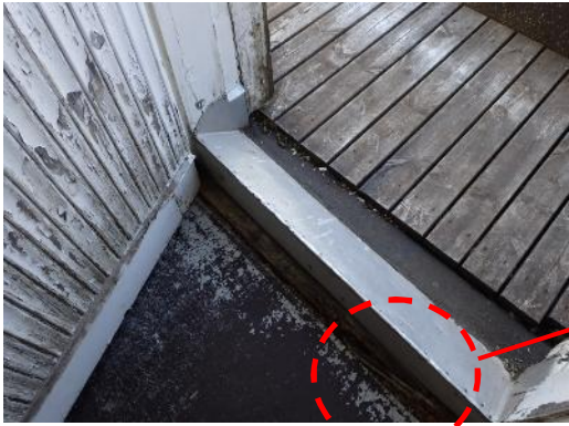
Kuva 35. Teknisen työn tilan ovi
