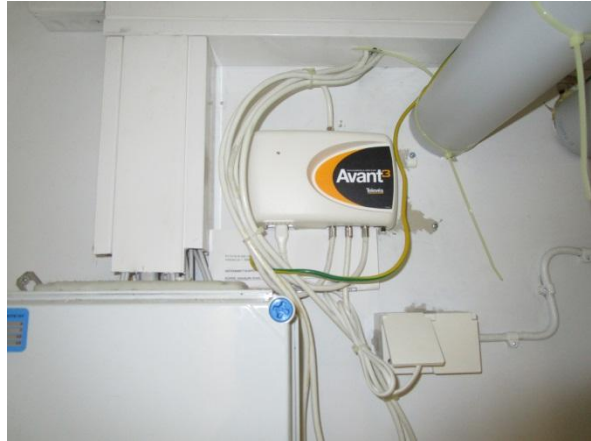
Kuva 110. Näkymää antennivahvistimesta (IV-tila).
