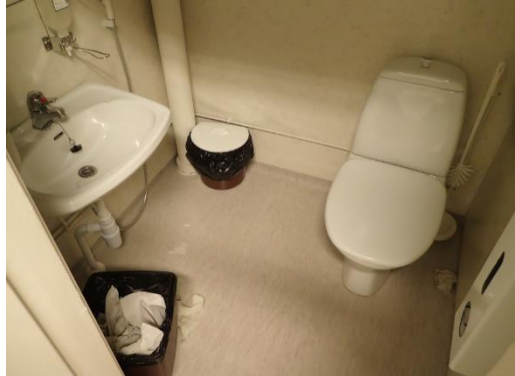
Kuva 66. Wc-tilassa lattiassa muovimatto ja seinissä muovitapetti
