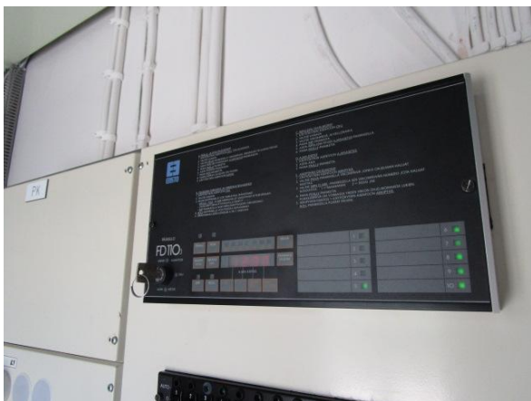
Kuva 113. Pääkellona toimiva laite (SPK-tila).
