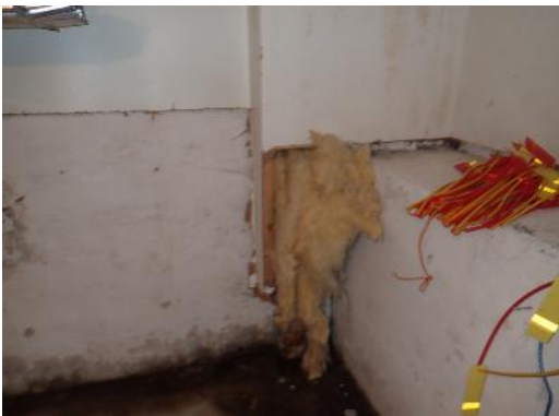
Kuva 18. Kellaritilan sisäseinärakenteita poistettu
