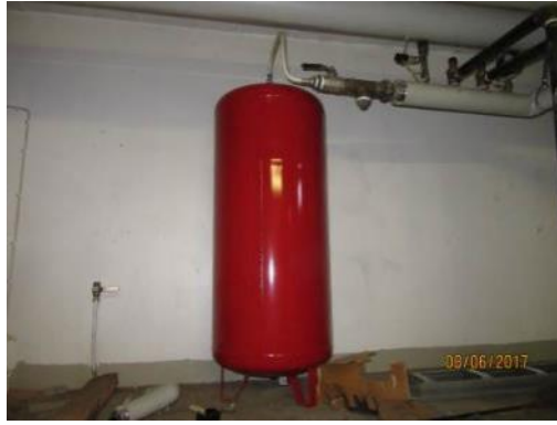
Kuva 77. Kalvopaisunta-astia
