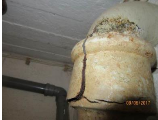
Kuva 54. Vanha valurautaviemäri
