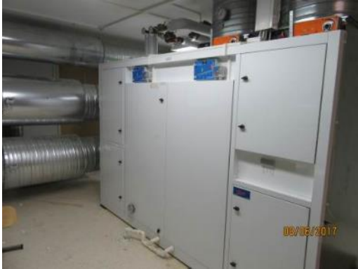
Kuva 61. Ilmanvaihtokone K1
