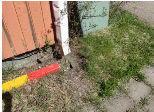
Kuva 10. Osittain kattovedet on ohjattu maahan
