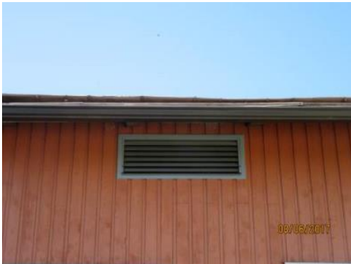
Kuva 63. Ilmanvaihtokoneen ulkoilmasäleikkö
