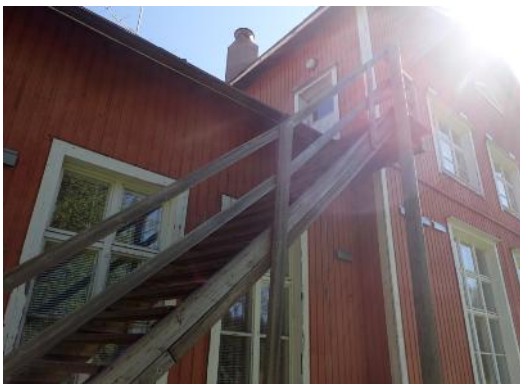
Kuva 39. Puiiset portaat lännenpuoleisella seinustalla
