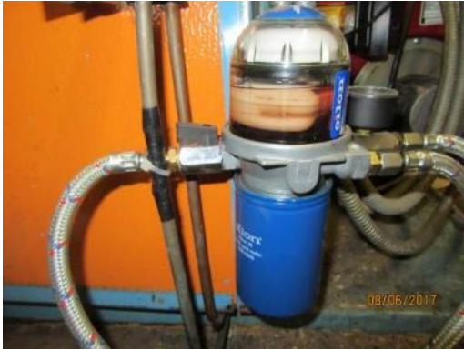
Kuva 76. Öljysuodatin
