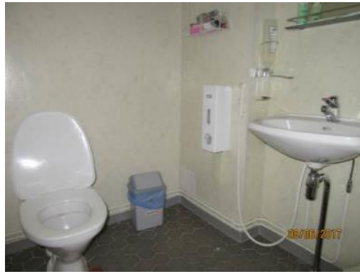
Kuva 87. Vesi- ja viemärikalusteet ovat kokonaisuutena tyydyttävässä kunnossa
