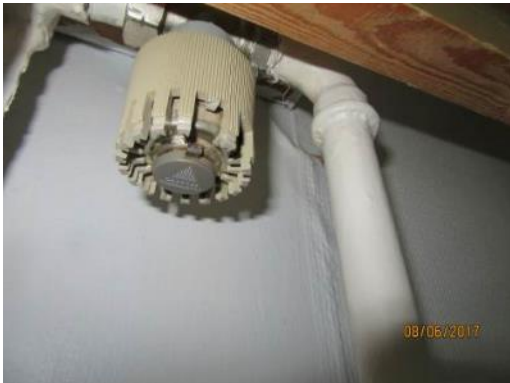
Kuva 82. Patteriventtiili
