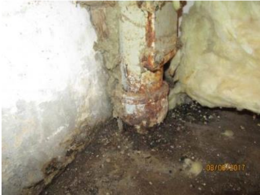
Kuva 53. Vanha valurautaviemäri
