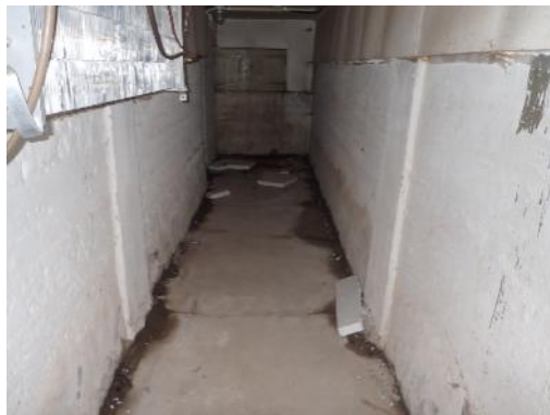
Kuva 19. Styrox-eristeitä poistettu seinien alaosaista
