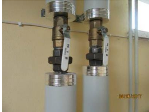
Kuva 81. Lämpöjohtovalventtiili
