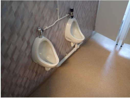
Kuva 67. Wc-tilassa lattiassa akrylibetoni ja seinissä muovitapetti
