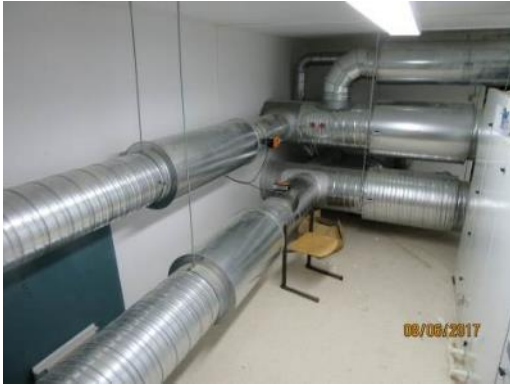
Kuva 65. Ilmanvaihtokanavia vuodelta 2002
