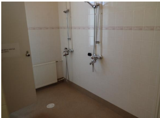
Kuva 68. Yleiskuva oppilaiden pesuhuoneesta
