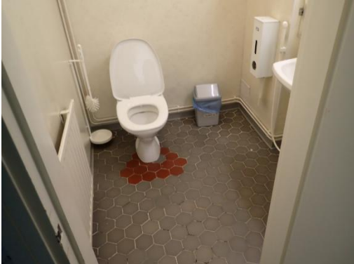
Kuva 65. Wc-tilassa lattiassa laatoitus ja seinissä muovitapetti
