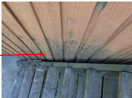
Kuva 25. Julkisivuverhouksessa lahovauriota
