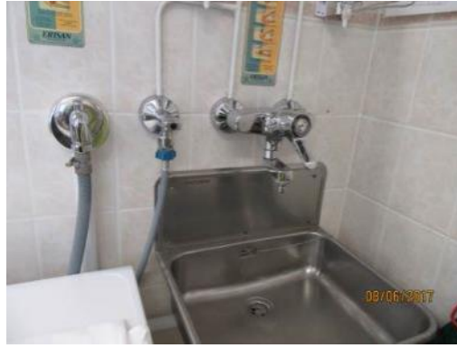
Kuva 85. Vesijohtojen kunto on hyvä
