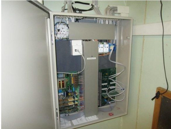
Kuva 117. Näkymä VAK-keskuksesta IV-tilassa.
