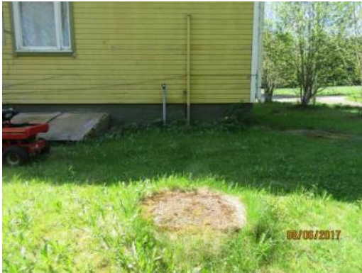
Kuva 78. Öljysäiliön huoltokaivon kansi
