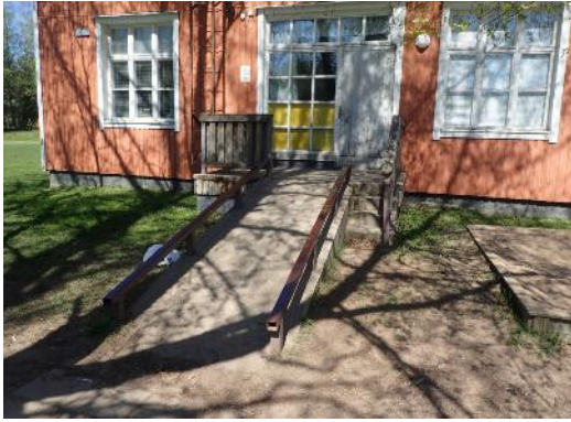
Kuva 43. Rakennuksen eteläpäädyssä betoninen luiska
