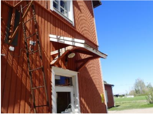
Kuva 37. Keittiön sisäänkäynnin kohdalla katos
