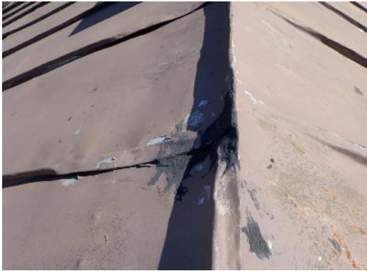
Kuva 47. Vesikatteen paikkakorjaus
