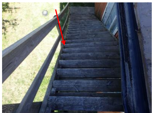
Kuva 40. Portaat ovat notkolla
