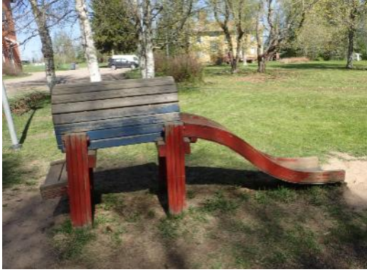
Kuva 7. Liukumäen puuosien maalipinnoite kulunut
