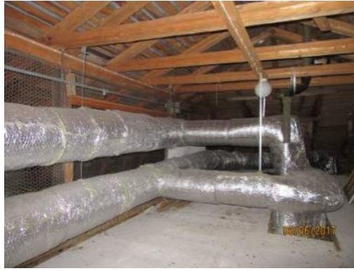
Kuva 66. Lämpöeristettyjä ilmanvaihtokanavia
