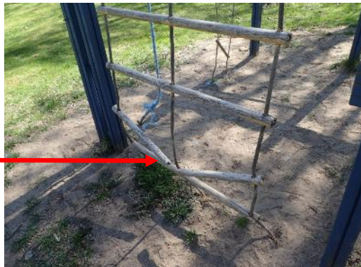
Kuva 6. Kiipeilytelineen tikkaat rikki
