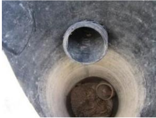
Kuva 12. Sadevesiviemärin putken pää nousee kaivossa ylöspäin
