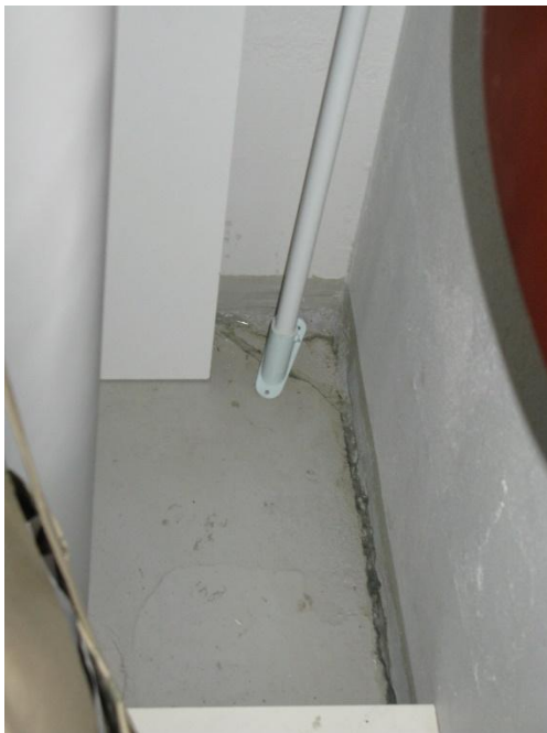
Kuva 19. Varaston 154 lattianraja on tiivistetty.
