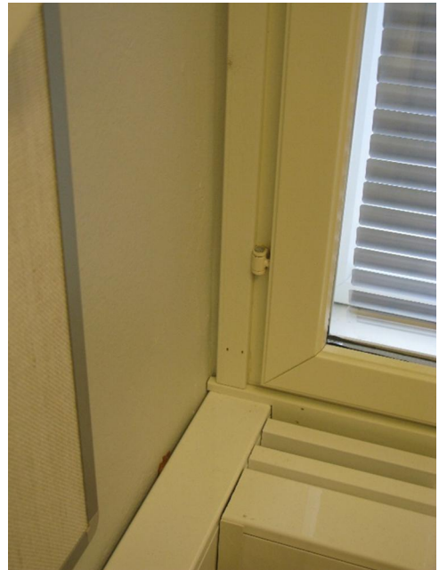
Kuva 13. Kouluavustajan huoneen 118 seinien ja ikkunan liittymä on tiivis.
