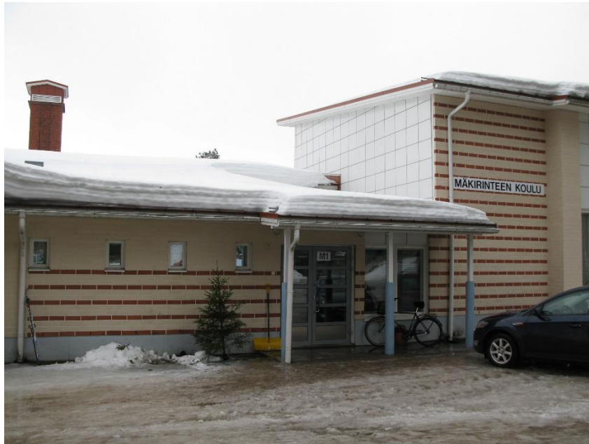
Kuva 3. Julkisivu sisäänkäynnin alueelta.
