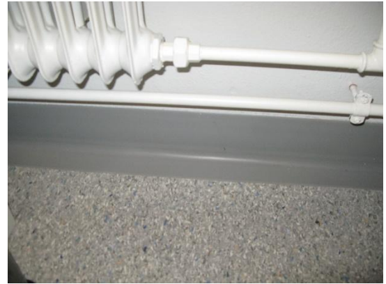
Kuva 9. Alapohjan ja ulkoseinän liittymä on tiivis.
